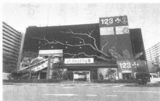
強いインパクトがある外壁
